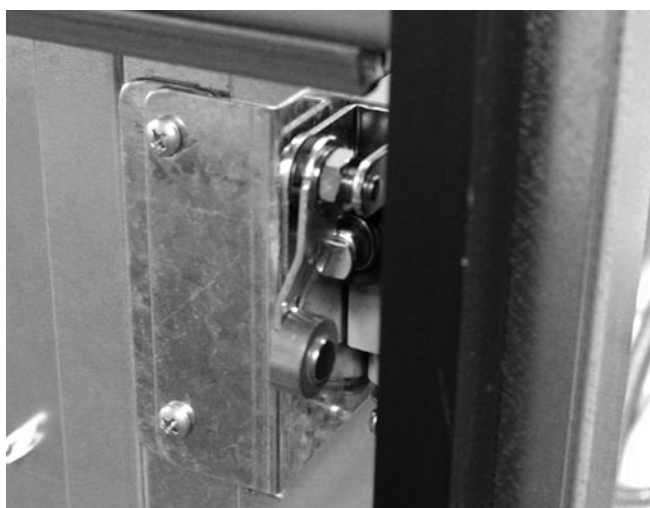
SP19 MICRO SWITCH (SASH DETECTOR)
